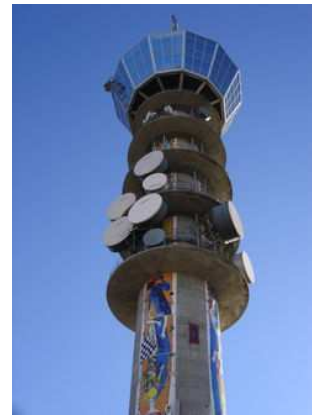
FIGURA 4: Torre emisora. La radiodifusión siempre se ha basado en buscar posiciones elevadas para el emisor. En países muy llanos hay que construir grandes torres (la contrapartida es que una torre sobre una llanura tiene un alcance enorme).
